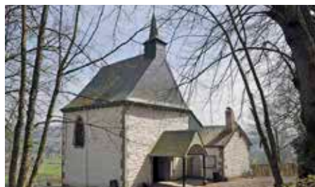
J. Nihon © Site de Montaigu
